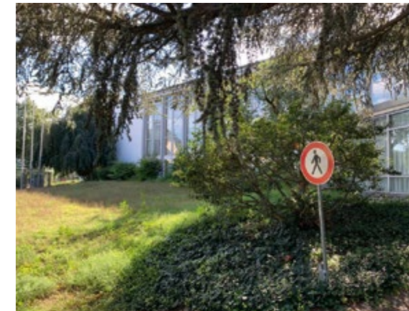
Stadthalle: einsturzgefährdeter Saal
